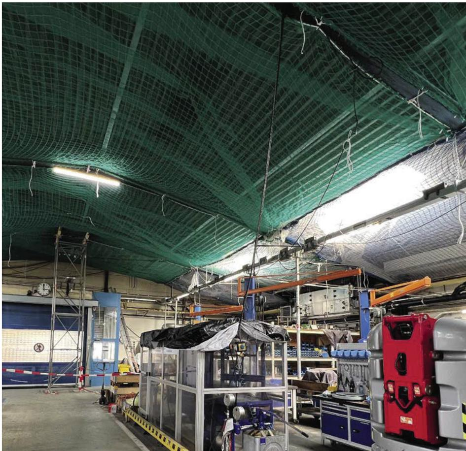
Personenauffangnetze inkl. Kleinteileschutznetz direkt unterhalb der Stahlkonstruktion mit Aufhängeseilen montiert
